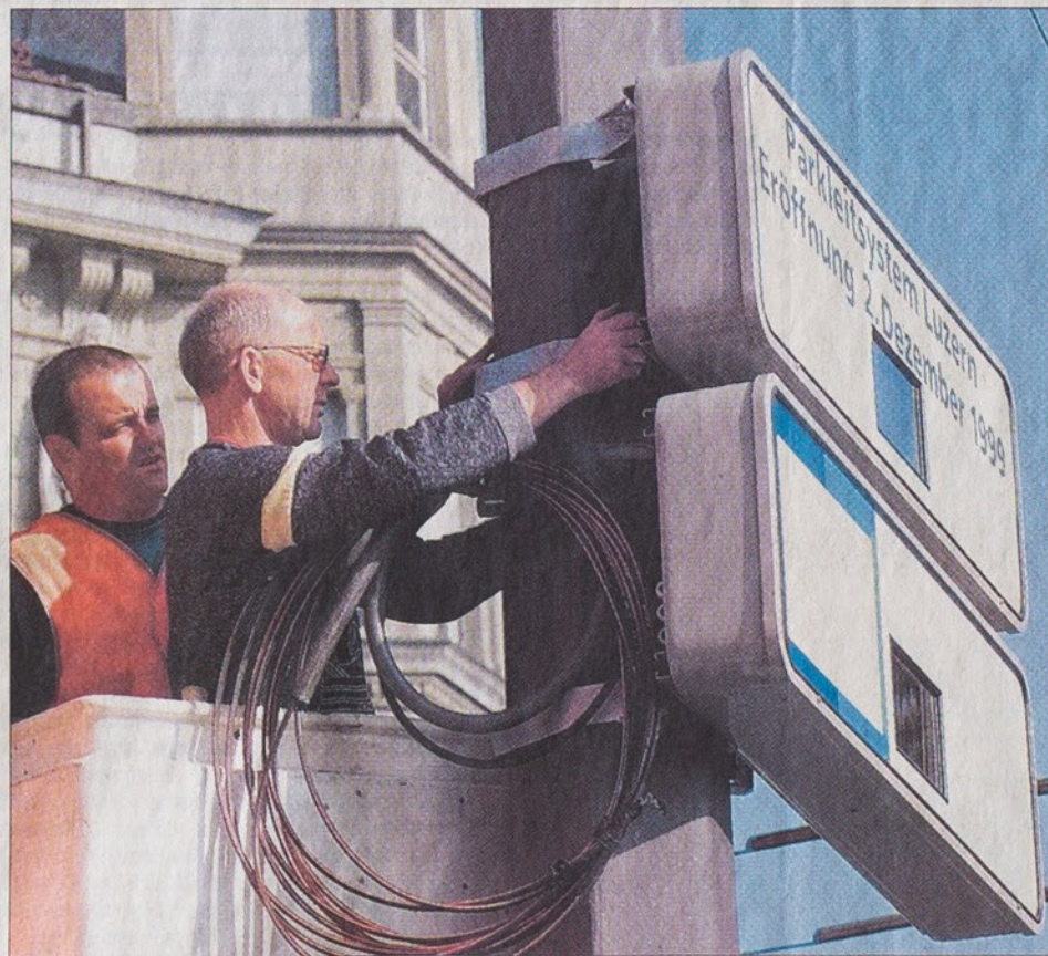
Gegenwärtig werden an 32 Standorten in der Stadt Luzern Leuchttafeln für das Parkleitsystem installiert.
